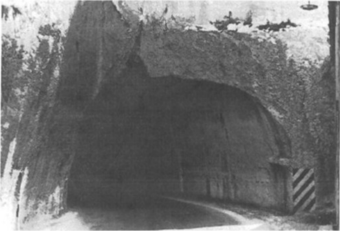
Fig. 3-1. Denne nydelig uthugne vegtunnelen på Via Flaminia mellom Rom og Rimini har tjent trafikken uten nevneverdig vedlikehold i 1900 år.
