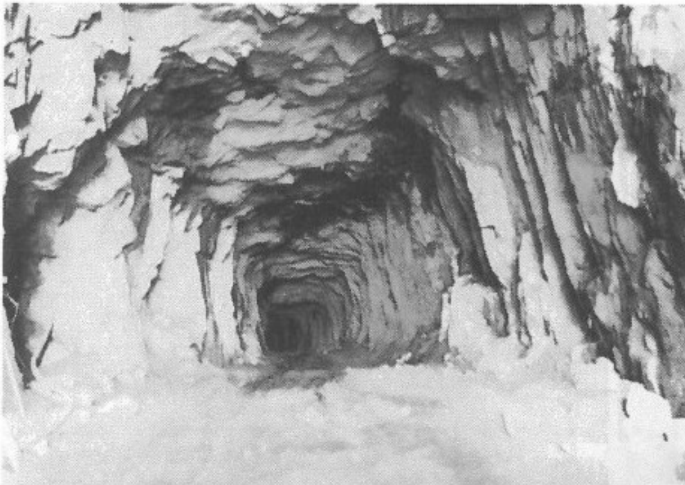
Fig. 3-3. Innføringen av sprengstoffet betydde en revolusjon for tunneldriften. Fotoet demonstrerer sprengningsmetodens viktigste ulempe, mindre muligheter for å oppnå en drift som skåner gjenstående berg. Fra en vegttunnel drevet i begynnelsen av 70-årene.
