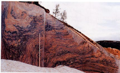
Figur 19. Ved diamantlinesaging av skjæringer oppnås at berggrunnens strukturer og monolittiske karakter kommer godt frem, samtidig med en mere miljømessig utførelse. Fra bruddet i Skjærstad-marmor. Noe for skjæringer i tettbebyggelse og parkmessige omgivelser? (Foto: H. Pantdalsli)
