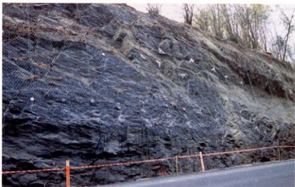
Figur 16. Stabilisering med bolting kan hindre utrasing og inngrep i overfliggende eiendom. I motsetning til betongkonstruksjoner eller forblending blir sikringen lite synlig, og gir mulighet for å presentere og studere berggrunnens egenart. (Foto: E. Iversen)
