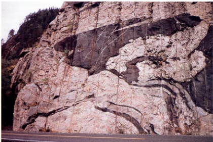
Figur 18. Dekorativ effekt av berggrunnsstrukturer i skjæring. (Foto: A. Grønhaug)
