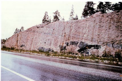
Figur 15. Ved slettsprengning får en frem geologiske strukturer som lett maskeres der det oppstår bakbrytning og utfall langs sprekker og slepper. I denne skjeringen i Østfold-granitt kommer den massive bergarten fint frem og avslører en innefrosset blokk av sideberget som falt inn i smeltmassen under styrkingen. I tillegg til en visuell opplevelse, er skjeringen blitt mer stabil og vedlikeholdsvennlig. (Foto: A. Grønhaug)
