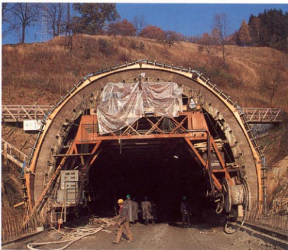
Figur 17. Tunneler påbegynnes i torven i Østerrike. (Foto: A. Granhaug)
