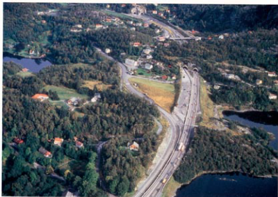
Figur 7. Vegtunneler er en effektiv løsning for å redusere inngrepene i landskapet. (Foto: Veien og Vi)
