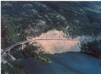
Figur 8. Tunneler er også en kostbar løsning, og vanskelig terreng forsøkes overvunnet på ulike måter. Her en kombinasjon av norsk (skjæring) og syd-europeisk løsning (viadukt). (Foto: K. Quarsten)
